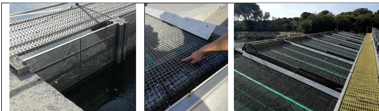
**Figura 72-** *A sinistra: tipologia di griglia disposta lungo una o più sezioni dei canali: Fibbia, Ansedonia e Nassa. Al centro e a destra: sgrigliatore posto nel canale di Nassa a valle (verso mare) del sistema di griglie.*
